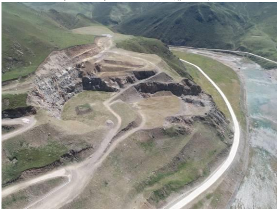
2#堆石料场恢复状
