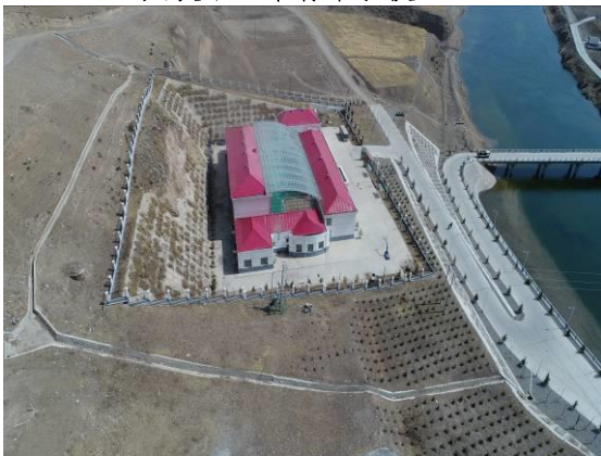
发电厂生活管理区周围截排水沟
