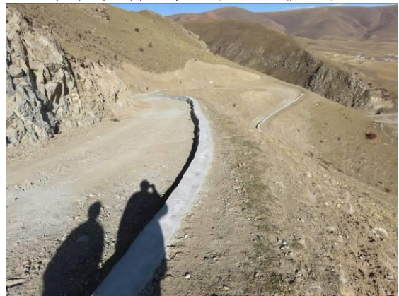
坝下游左岸上坝公路浆砌石挡水堰
