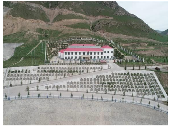
石头峡水电站发电厂房
