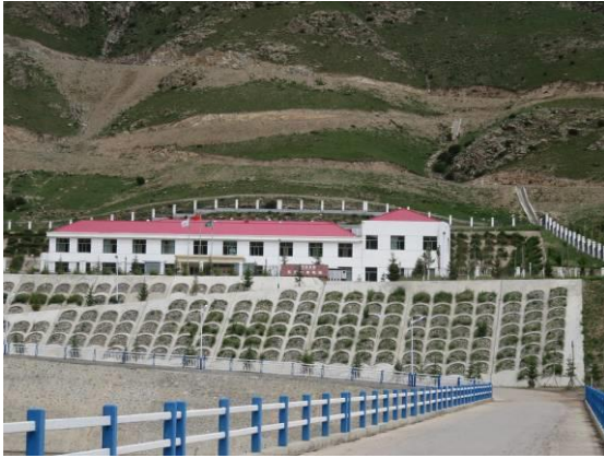
石头峡水电站骨架护坡
