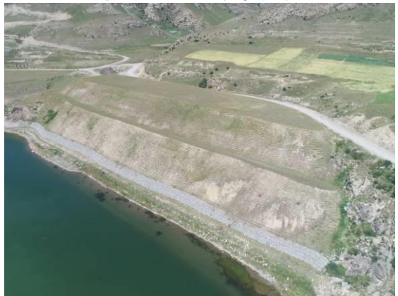
1#弃渣场挡渣墙、分级削坡、植被恢复
