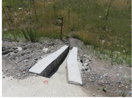
YD1 永久道路两侧急流槽
