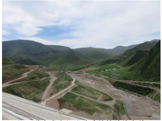
坝下游左岸上坝公路边坡植被恢复状
