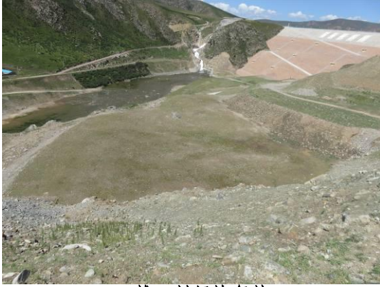
2#堆石料场恢复状
