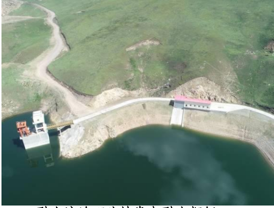
引大济湟石头峡发电引水枢纽
