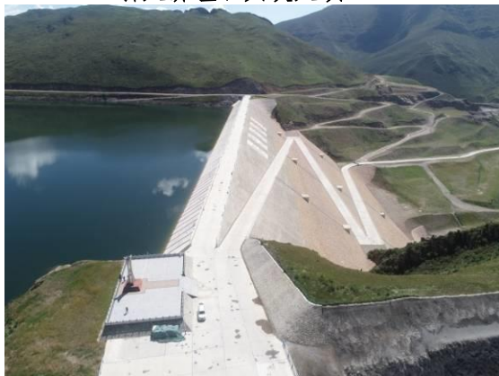
引大济湟石头峡大坝“之”字路
