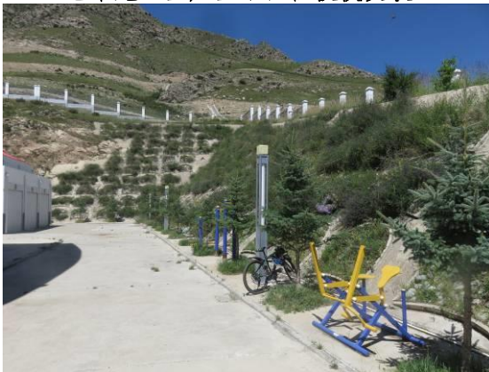
电站生活管理区骨架护坡植被恢复
