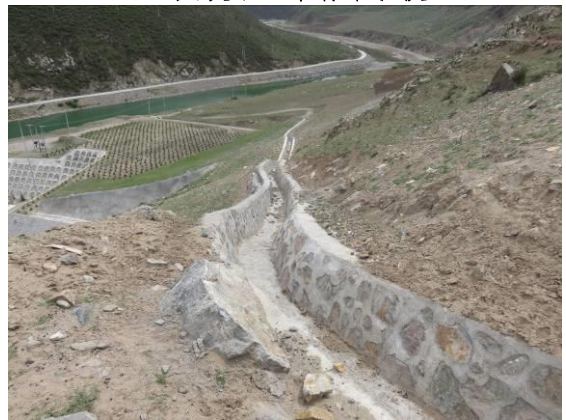
发电厂生活管理区周围截排水沟
