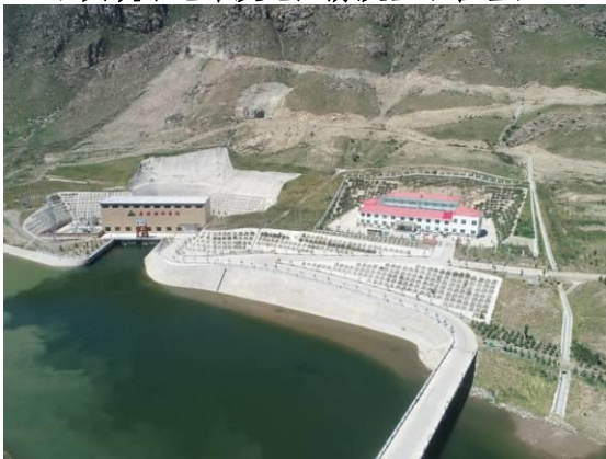
石头峡水电站发电厂房及生活管理区
