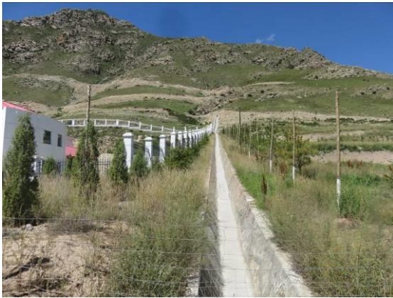
电站生活管理区周围排水沟
