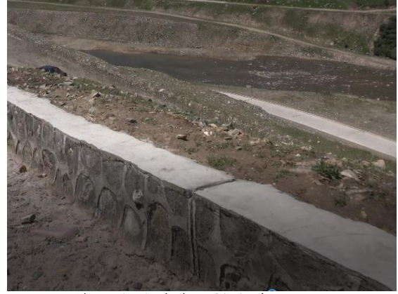
施工临时道路区排水沟
