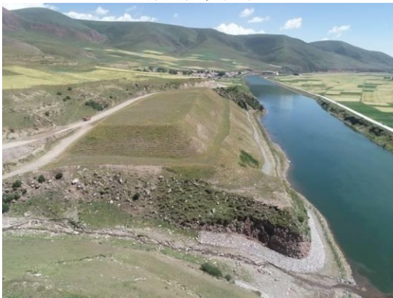
1#弃渣场挡渣墙、分级削坡、植被恢复
