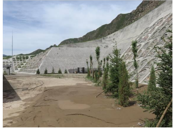
石头峡水电站骨架护坡
