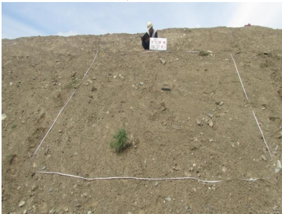
弃土场边坡面监测点
