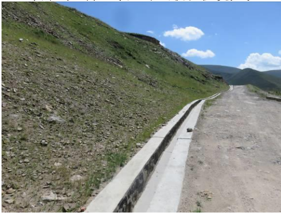
坝下游左岸上坝公路 LD1 排水沟
