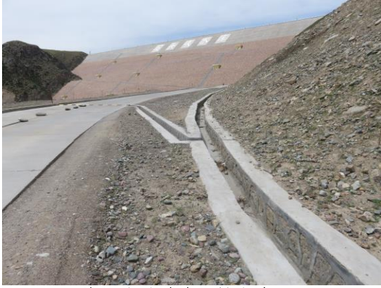
施工临时道路区排水沟
