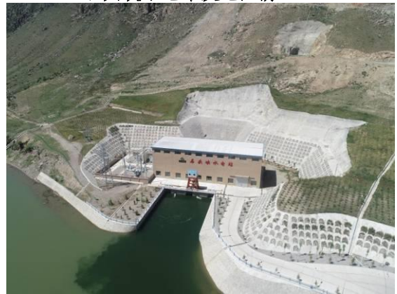
石头峡水电站发电厂房
