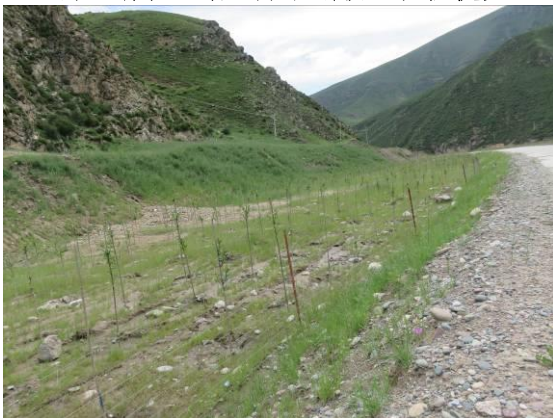
交通桥引道及混凝土骨料场整治恢复状
