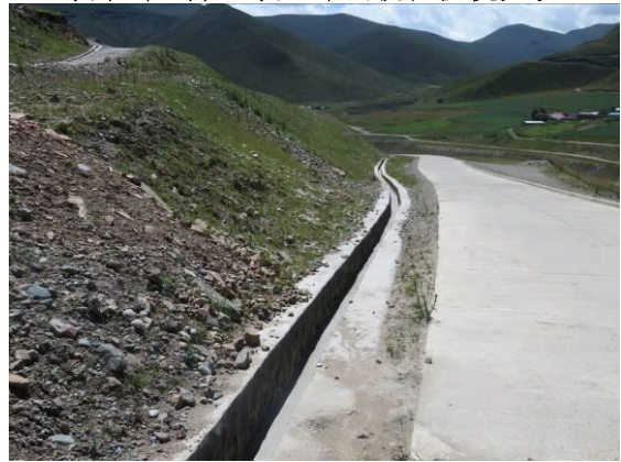
坝下游左岸上坝公路 LD1 排水沟
