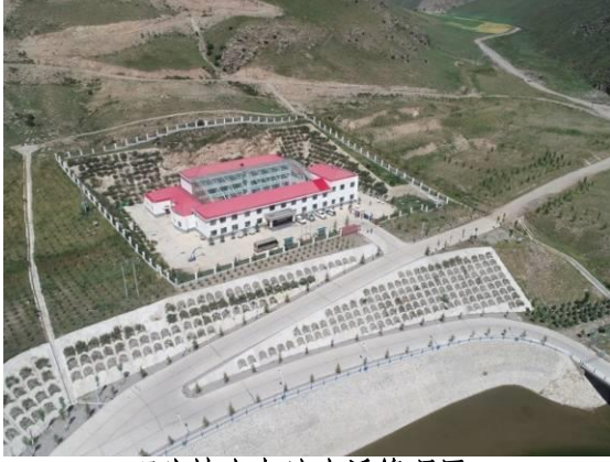
石头峡水电站生活管理区
