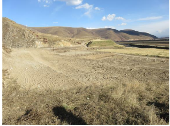
电站施工生产生活区土地整治及覆土
