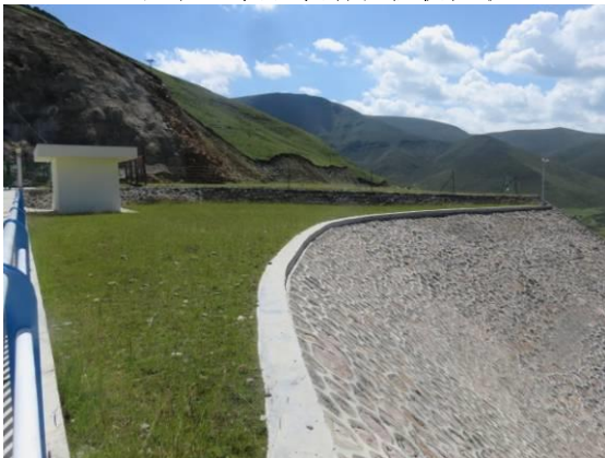
石头峡大坝坝肩植被恢复
