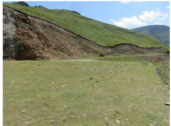
石头峡大坝坝肩植被恢复
