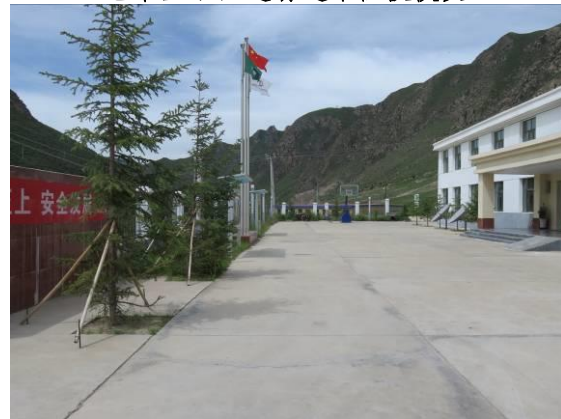
电站生活管理区植被恢复
