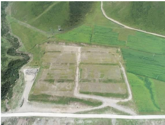
大坝施工生产生活区植被恢复状
