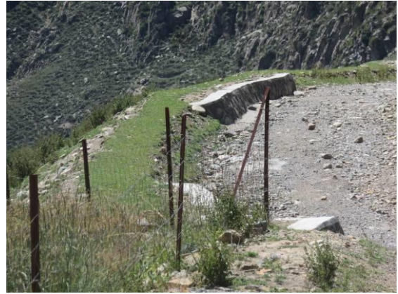
施工道路外沿挡水堰
