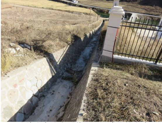
石头峡水电站生活管理区周边截排水沟
