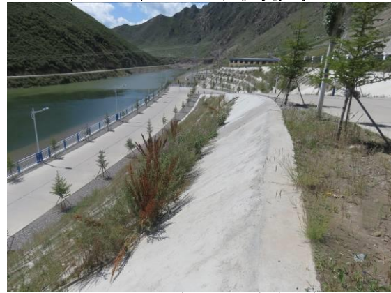
电站生活区进场道路植被恢复
