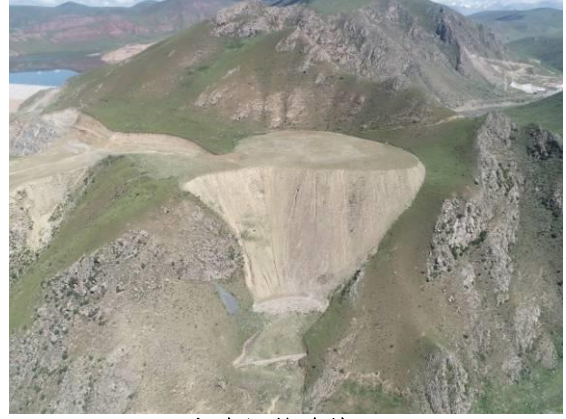
2#弃渣场整治状
