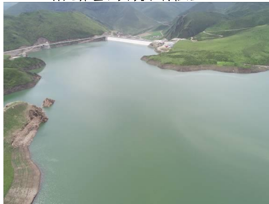
引大济湟石头峡大坝库区
