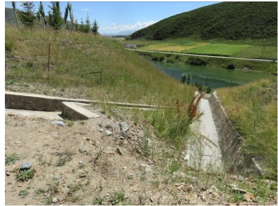
电站厂房周围排水沟
