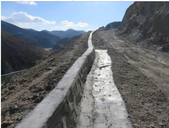
坝下游左岸上坝公路浆砌石挡水堰
