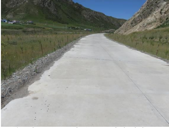
交通桥至大坝混凝土 YD1 永久道路
