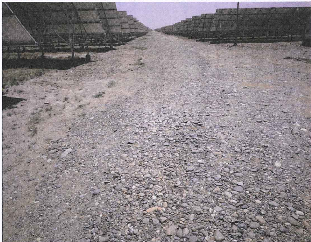
光伏场区现场照片
