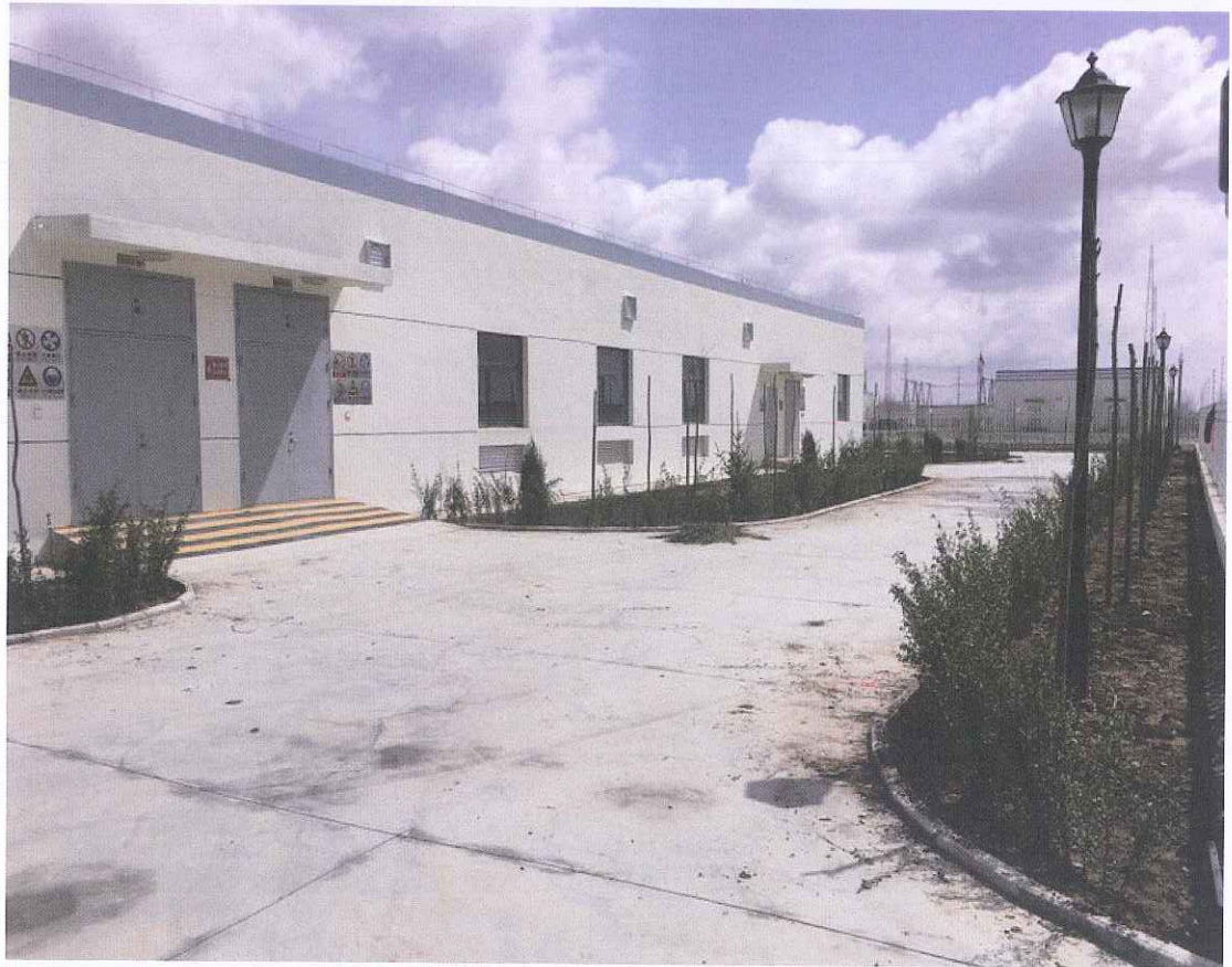
35kV 开关站绿化完成情况
